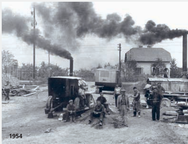
Polaganje temeljev za Centralno skladišče Ljubljana
