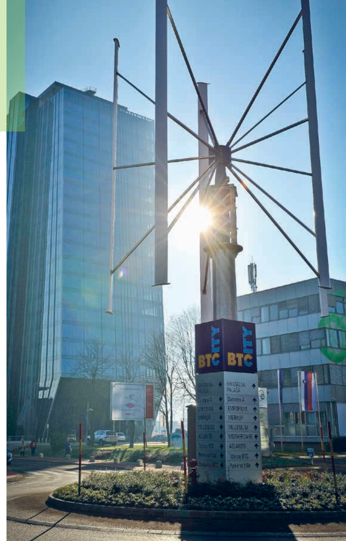
Vetrna elektrarna pri vhodu v BTC City proizvede do 240.000 kWh elektrike letno.
